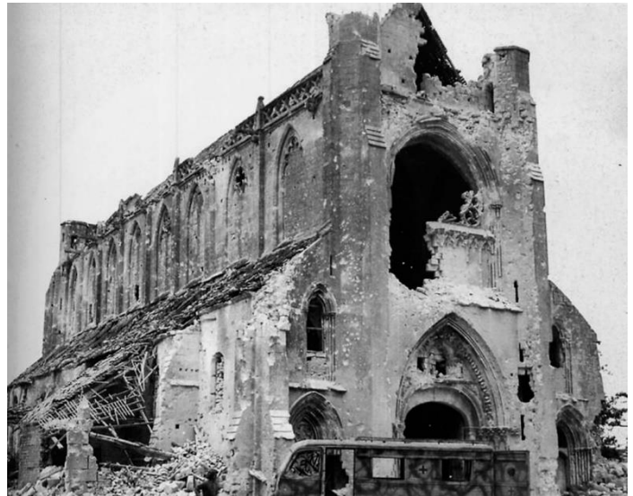
Die Abtei d'Ardenne nach der Schlacht von Cean, Juli 1944. Im Vordergrund ist ein ausgefallener Fiat 626N Krankenwagen zu sehen.
